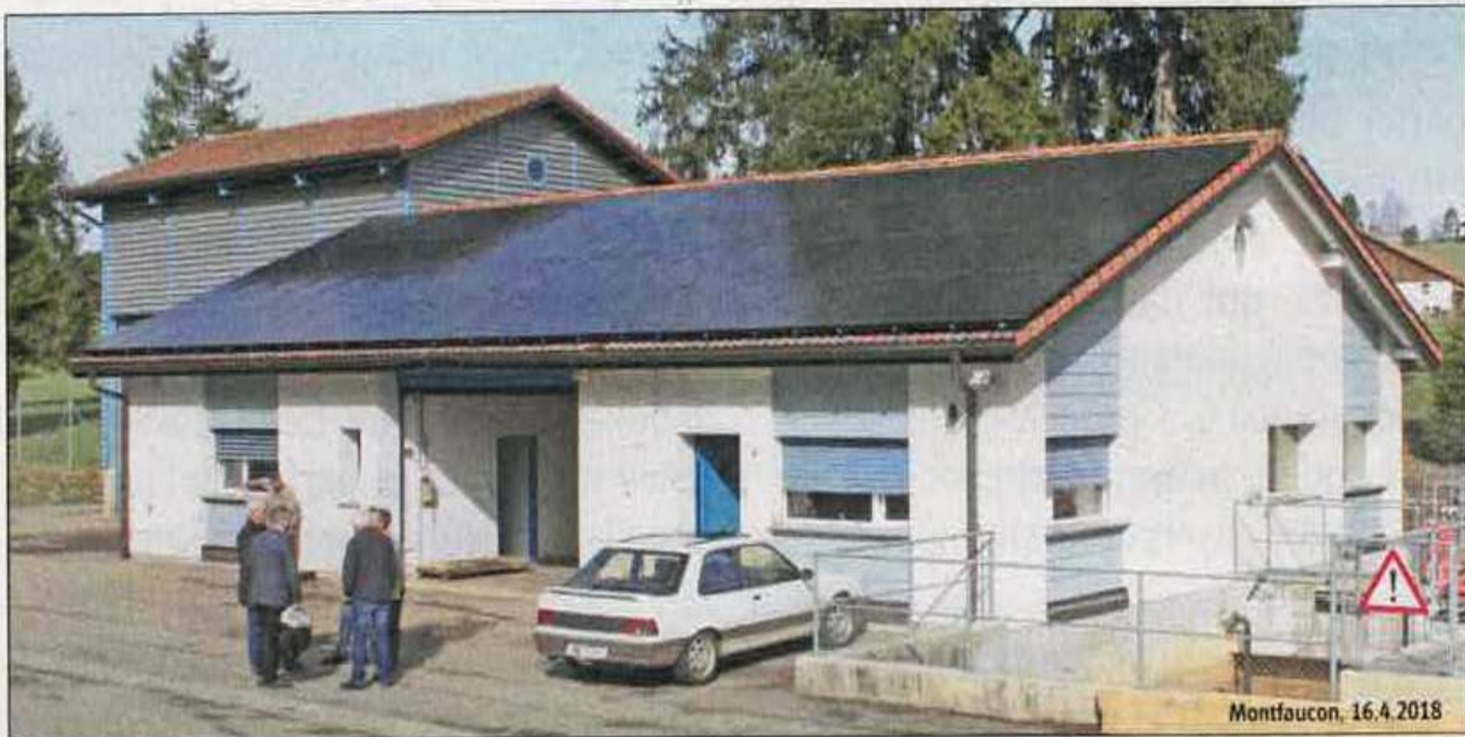
Les panneaux photovoltaïques continuent de briller aux Franches-Montagnes. Après le projet mené sur la Step à Montfaucon l'année passée, des démarches pour en installer d'autres sont en cours dans plusieurs endroits du district.
